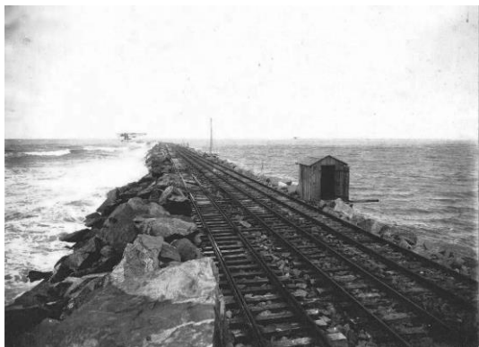
Figura 3 – Construção do Molhe Oeste, 1904. Fonte: Acervo do Século XX – Molhes da Barra, Biblioteca do Porto do Rio Grande.
